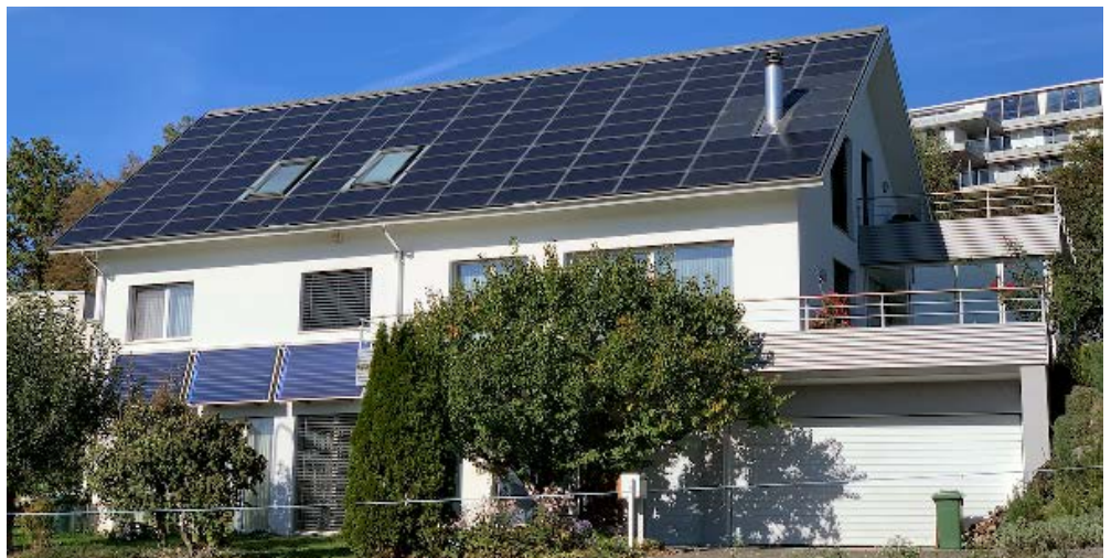
Die dachintegrierte 11,7 kWp-Photovoltaikanlage produziert seit 23 Jahren durchschnittlich 11 250 kWh pro Jahr bei einem jährlichen Stromverbrauch inkl. Heizung von rund 7 000 kWh, dabei wird die Heizung von drei Warmwasserkollektoren an der Fassade unterstützt.
