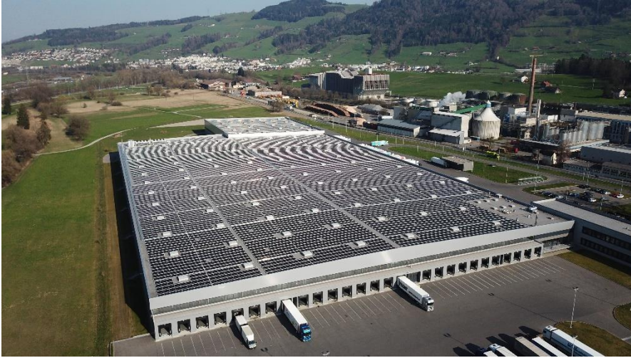
Aldi SuissewVerteilzentrum, Perlen, 6'460 kWp Bildquelle: BE Netz
