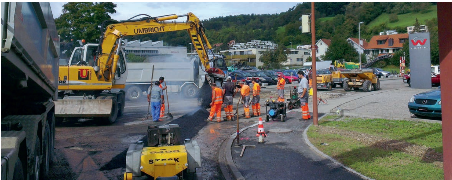
Mitarbeiter der Bauunternehmung Umbricht AG beim Belagseinbau.
