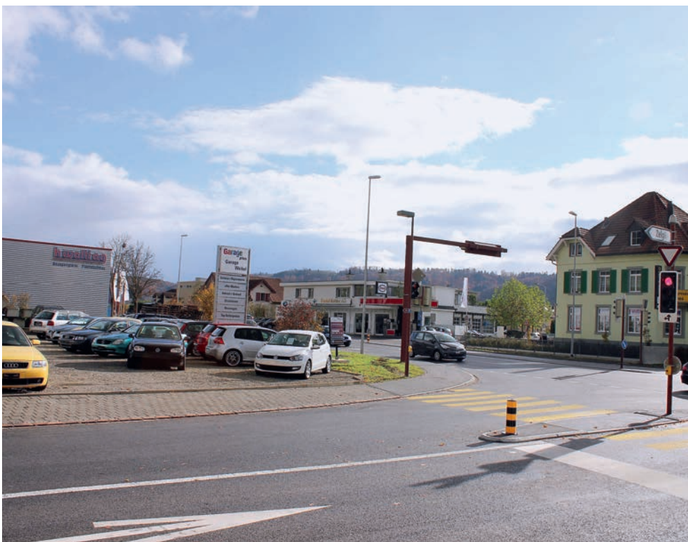
Kreuzung Schöneegg nach Abschluss der Arbeiten.
