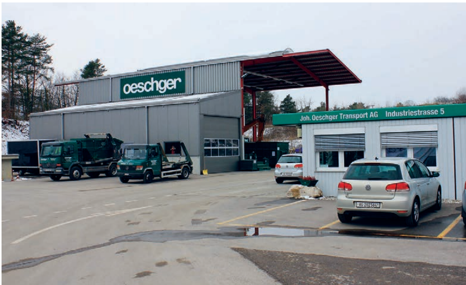
Entsorgungsstelle im Industriegebiet Hard.
