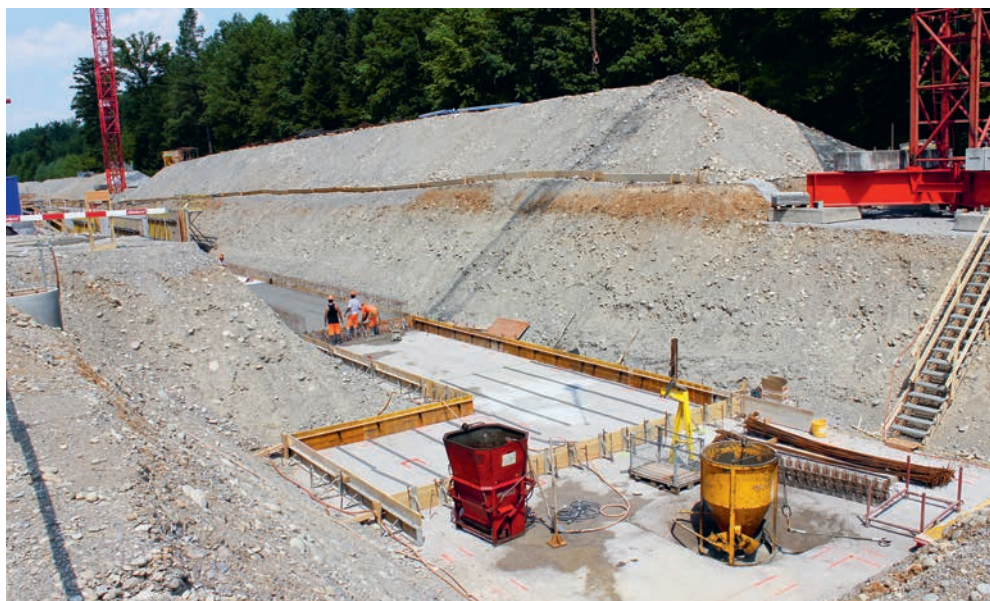
Ein Blick auf die Baustelle.
