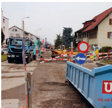
Die Baustelle an der Dorfstrasse.
