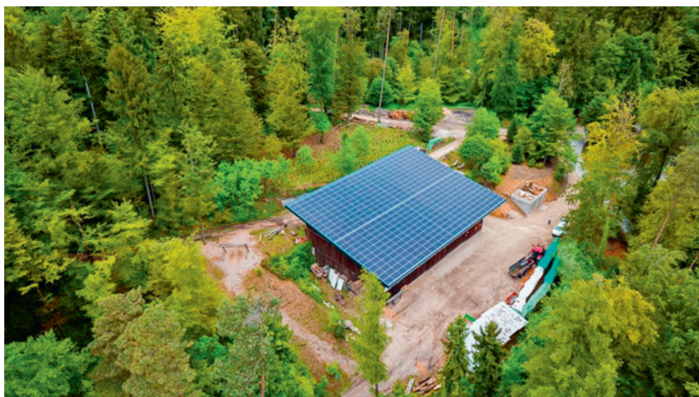
Die Solaranlage auf dem Forstschopf Rotchrüz ist seit 2014 in Betrieb (ge).
