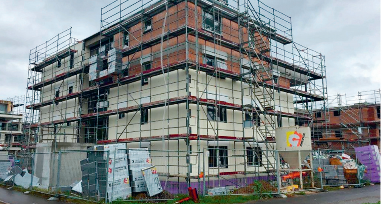
Energiebewusstes Bauen ist heute eine Selbstverständlichkeit - hier die Baustelle «Im Bungert» (uz).
