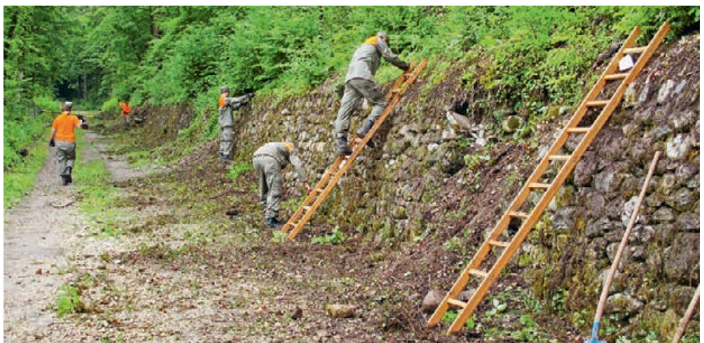
Freilegung Stützmauer «Alte Landstrasse Bern–Schaffhausen», WK 2015.
