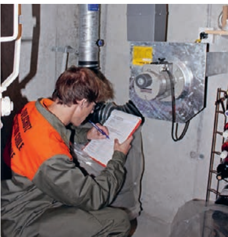
Die Checkliste wird Punkt für Punkt abgearbeitet.
