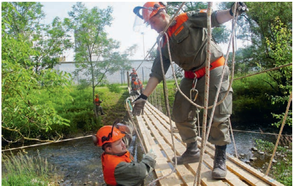
Einbau von mehreren Bachsperrn In Turgi, WK 2015.
