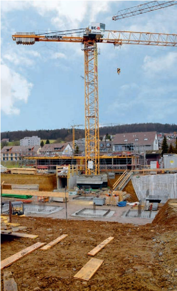
Baubeginn bei der Überbauung der Wohnbaugenossenschaft Siggenberg.
