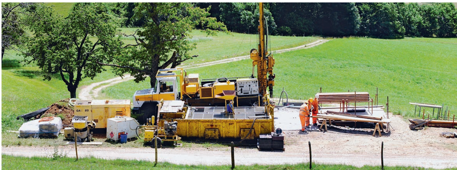
Eine Bohrbaustelle der Nagra (Comet Photoshopping).
