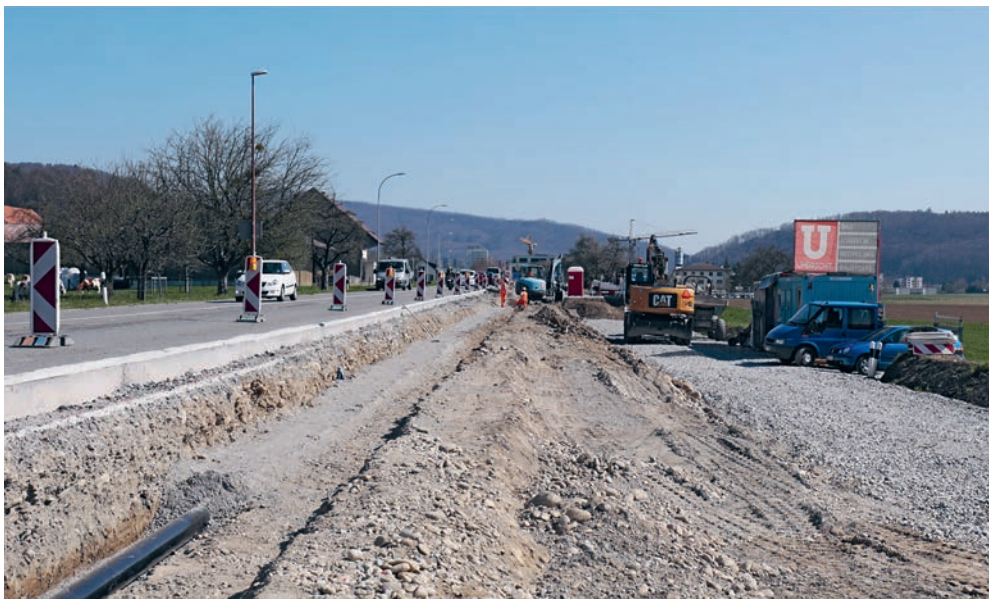
Baustelle an der Landstrasse K114 mit der neuen Wasserleitung.
