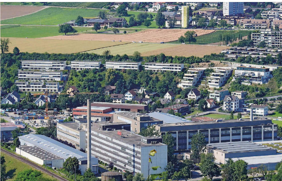
Die Auhalde wird derzeit (hinter dem Kranarm) verdichtet durch den Bau eines Mehrfamilienhauses.
