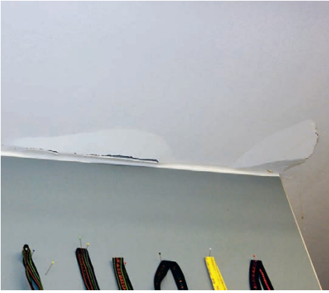
Die Decke im TW-Raum, Haus C.
