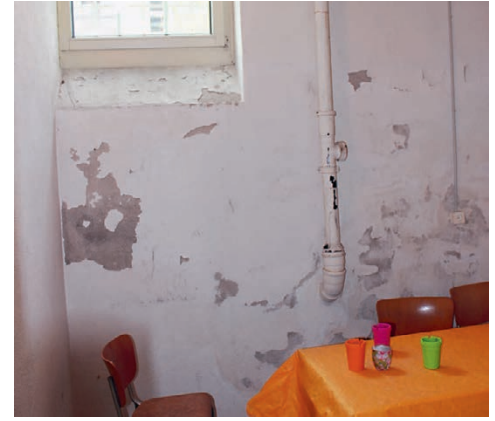
Lehrpersonen-Pausenraum im Keller Haus A.
