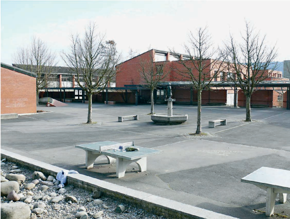
Pausenplatz und Aussenanlagen sind in gutem Zustand.
