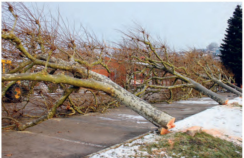
Baumfällarbeiten für den neuen Dorfplatz
