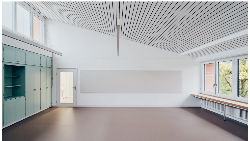
Die Klassenzimmer sind heller und haben eine neue Akustikdecke.
