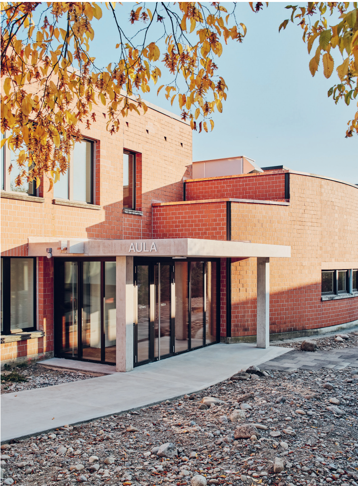
Der neue Eingang zur Aula
