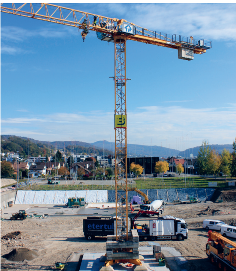
Aufbau des Krans in der Baugrube, 25.10.21
