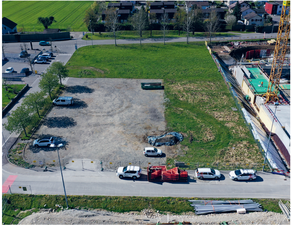
Der noch «unberührte» Baugrund des Zentrums «Mardel»
