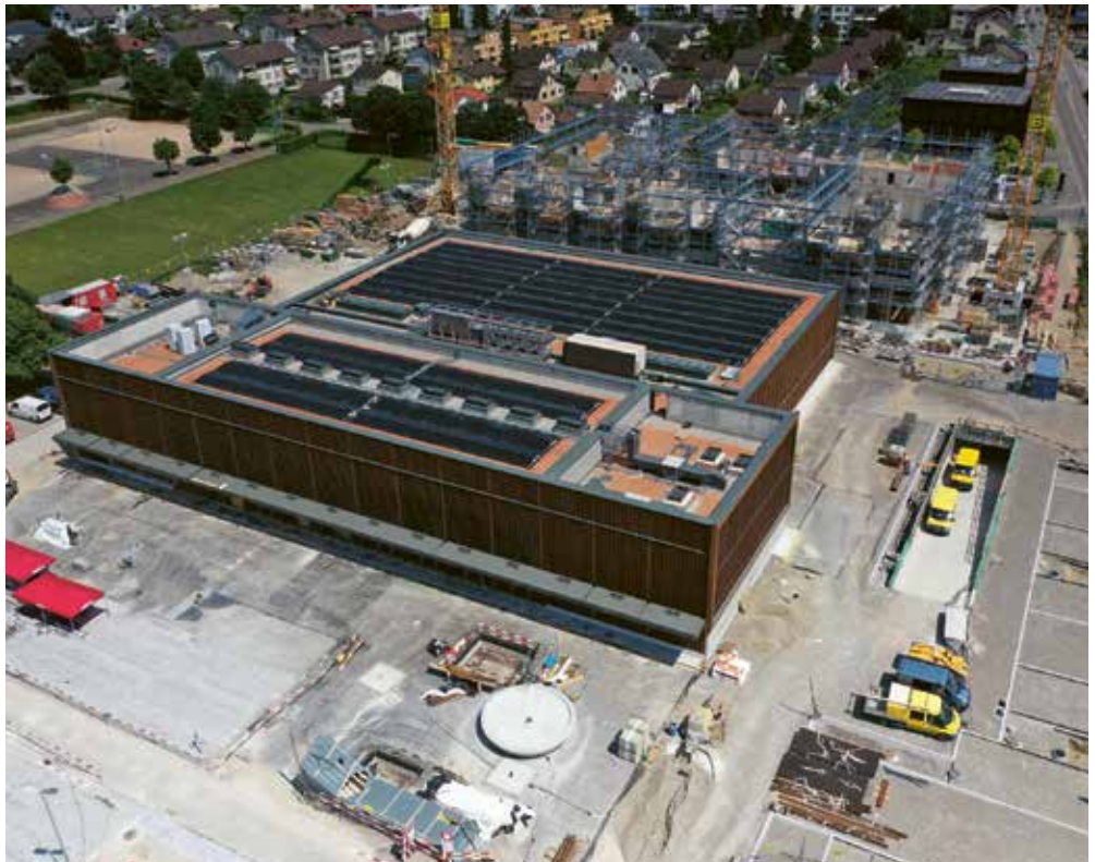
Die grosse Baustelle im Zentrum Untersiggenthals.
