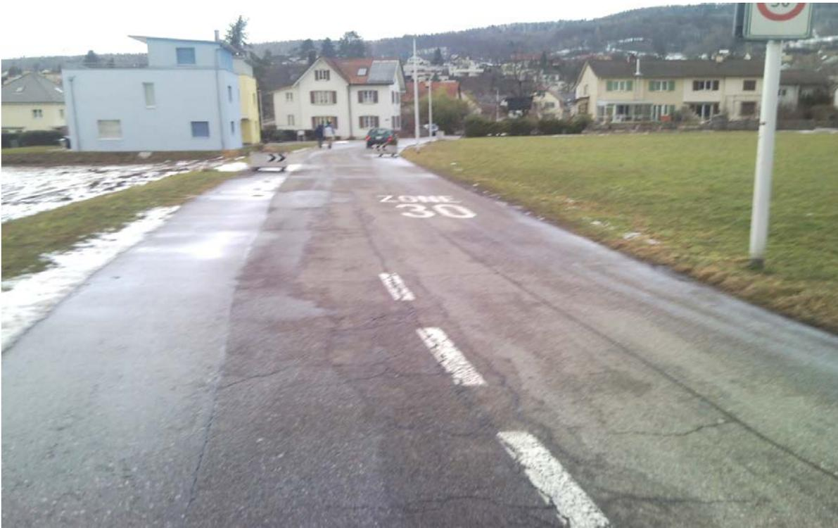
Da die Hölzlistrasse in einem schlechten Zustand ist und vor allem keine Entwässerung vorhanden ist, wird die ganze Strasse zusammen mit der notwendigen Entwässerungsverbesserung saniert bzw. neu erstellt. In diesem Zusammenhang soll die bisher provisorische 30-Zone-Signalisation neu und definitiv erstellt werden.
