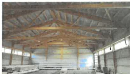
Neue Kommissionierungshalle (Fagus Suisse)
