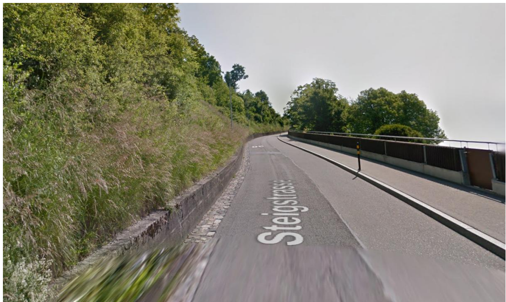
Abbildung 28: Steigstrasse in Fahrrichtung Norden auf Höhe Steigstrasse Nr. 15 (Google Maps, Aufnahme vom Juni 2013)
