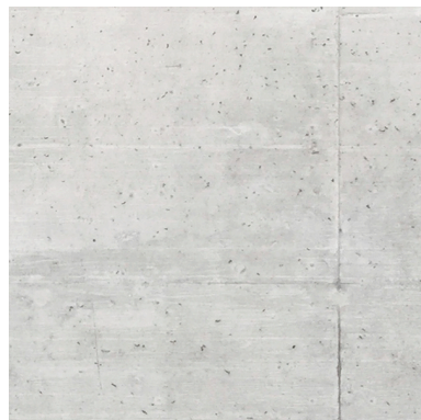
Terrassenbrüstungen Sichtbeton hydrophobiert
