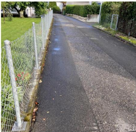
Abbildung 1: IST-Zustand Foto Birkenweg (12.06.2024)
